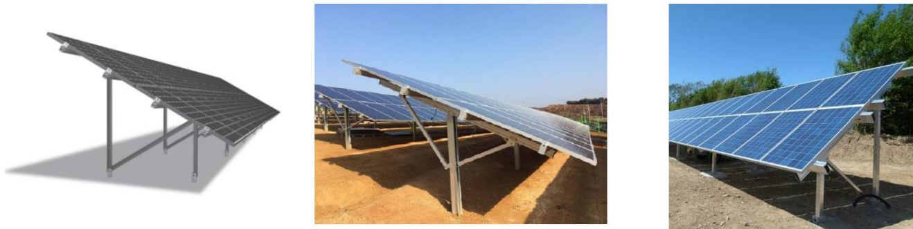
Figure 57 : Exemples de structures photovoltaïques avec pieux battus « zone 1 »
