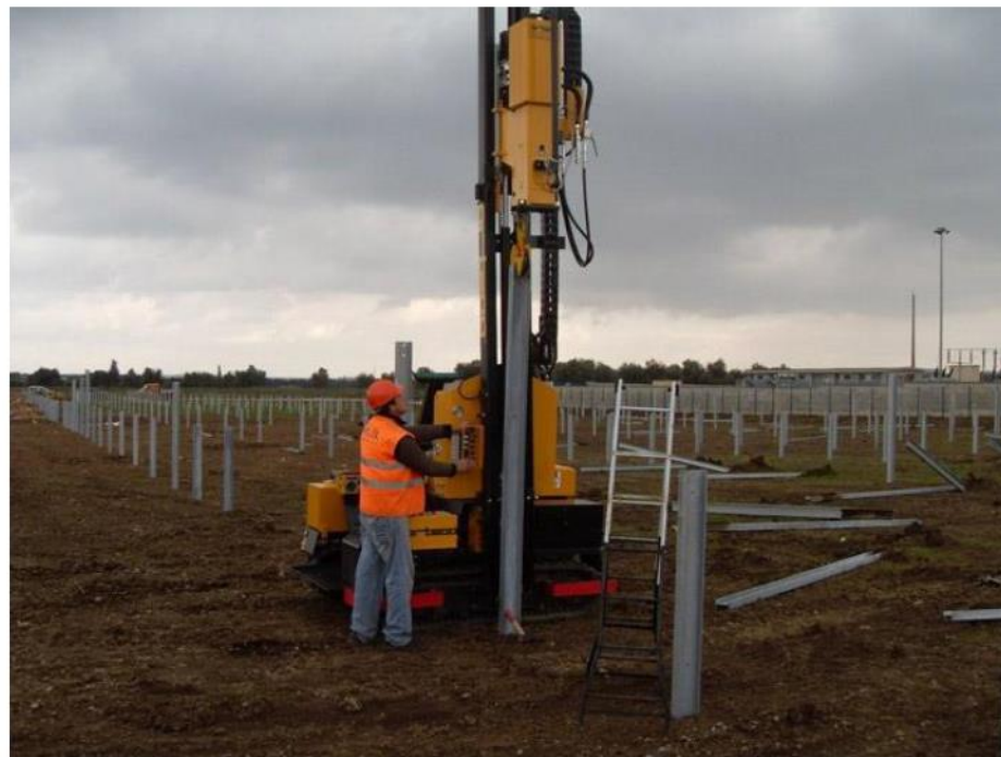
Figure 65 : Exemple d'enfoncement de pieux battus pour la mise en œuvre d'un parc photovoltaïque (Source : http://www.pajot.com/applications/ )
