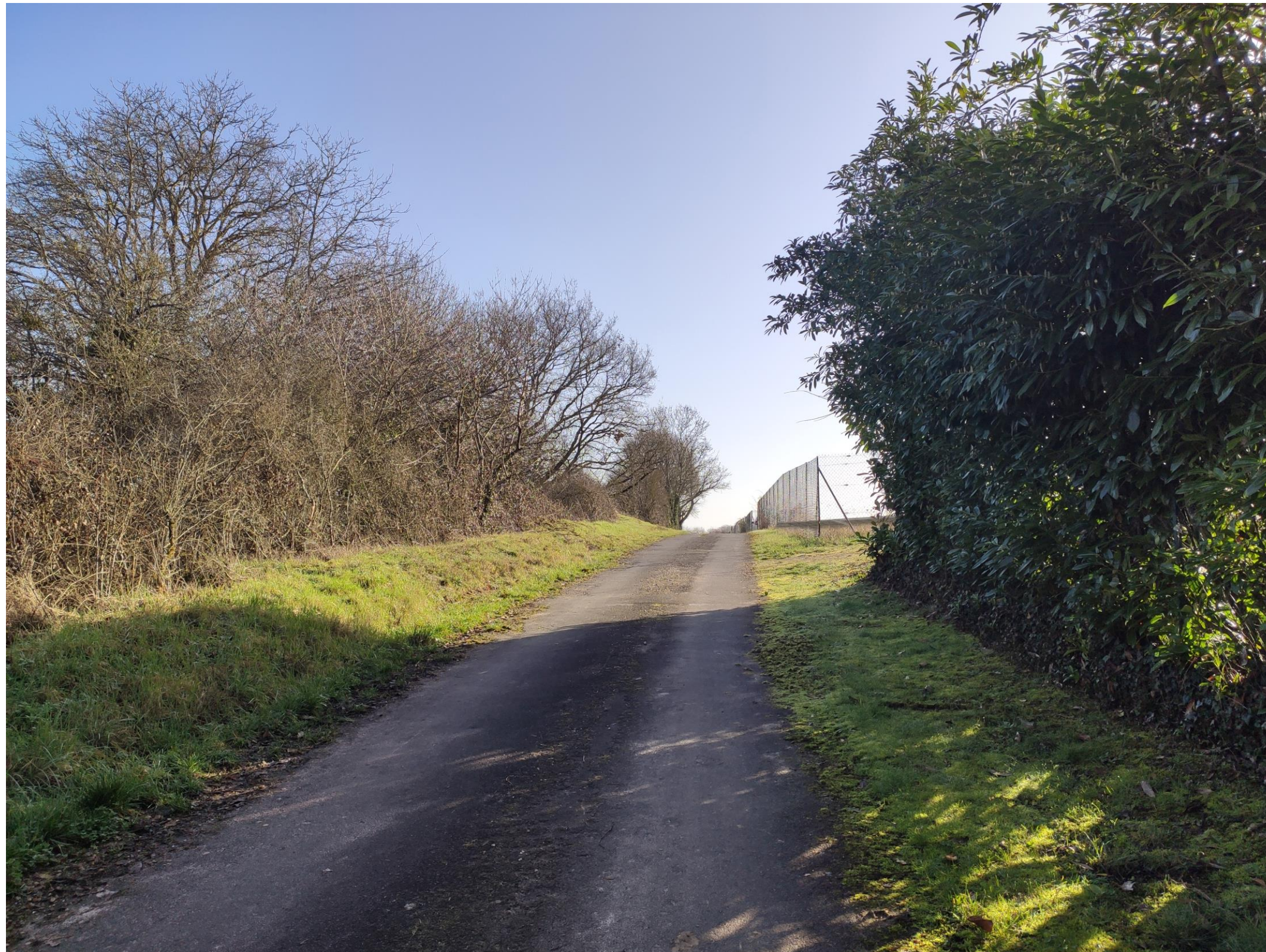
Figure 73 : Photomontage illustrant la perception depuis le chemin de Courcelles après implantation de la centrale
