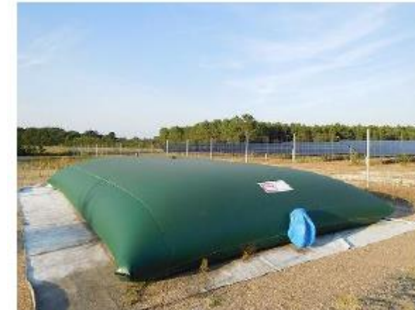
Figure 62 : Exemple d'une bâche incendie
